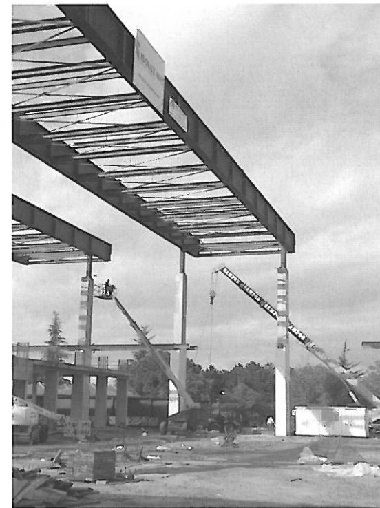
Figura 6.- Montaje de vigas de cubierta.
