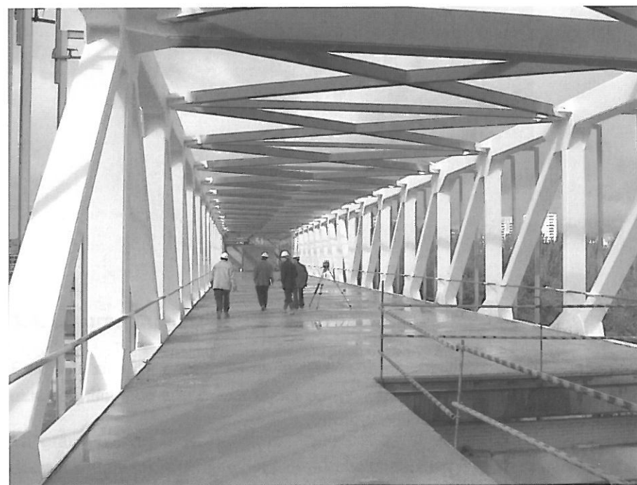
Figura 4.- Vista interior del edificio-puente.
