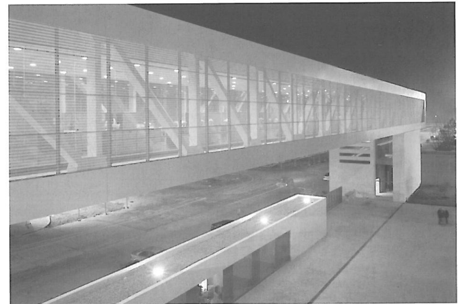
Figura 2.- Vista nocturna del edificio-puente.
