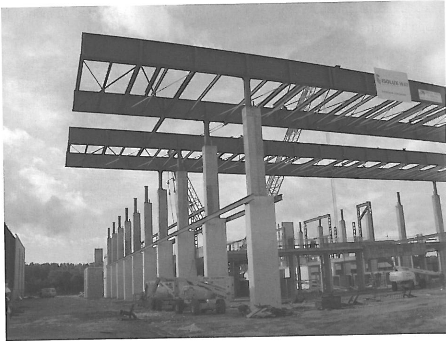
Figura 7.- Voladizo y montaje de la cubierta.
