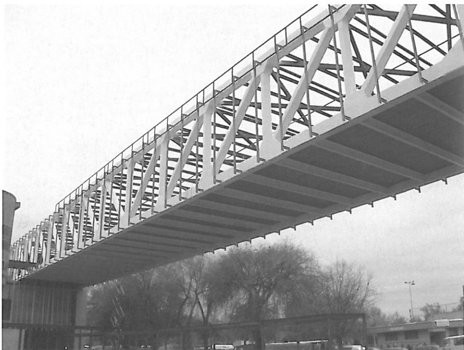
Figura 3.- Celosía del edificio-puente.
