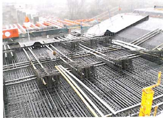
Figura 7. Colocación de vainas de pretensado longitudinal en el último tercio del tablero Figure 7. Positioning longitudinal prestressed sheaths in the last third of the deck
