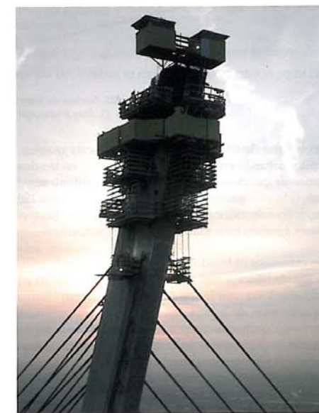
Figura 20. Encofrado autoretrepante Figure 20. Self-climbing formwork
