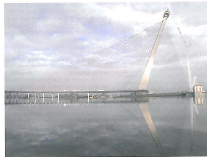
Figura 39. Construcción del pylon, tesado de cables y eliminación de pilas según avance del tesado Figure 39. Pylon construction, cable stressing and pier removal
