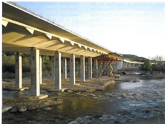
Figura 34. Tablero apoyado sobre pilas provisionales. Al fondo el viaducto de acceso Figure 34. Deck resting on provisional piers with approach viaduct in the background
