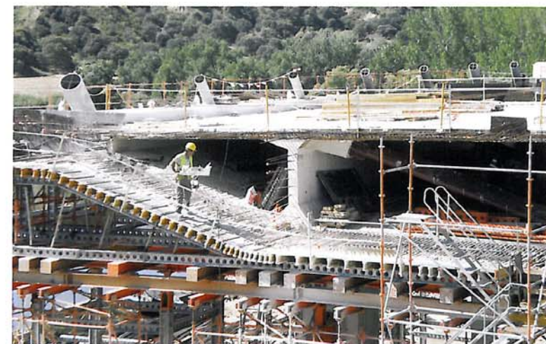
Figura 5. Diagonales del diafragma colocadas en hueco rectangular de la sección Figure 5. Diaphragm diagonals in the rectangular space in the cross-section
