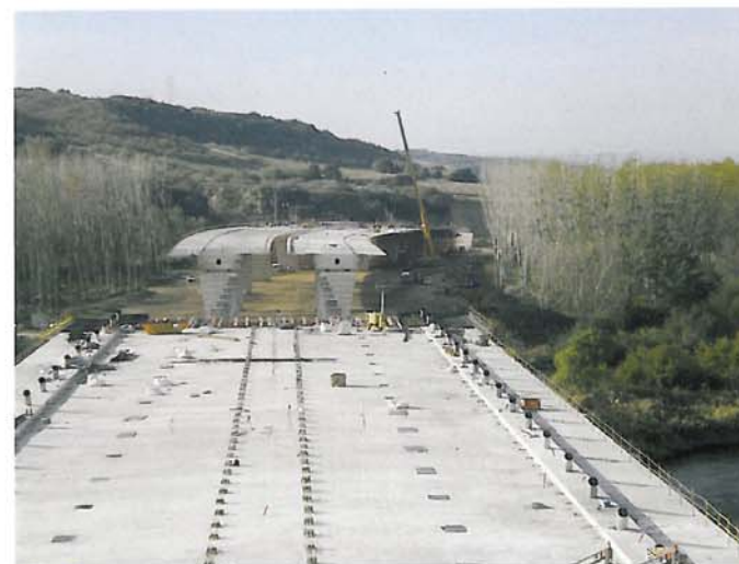
Figura 36. Avance del tablero del puente atirantado. Al fondo, los tableros del viaducto de acceso Figure 36. Cable-stayed bridge deck construction with the approach viaduct decks in the background
