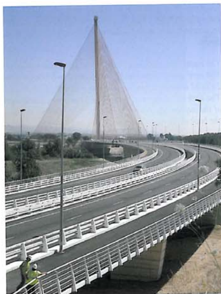
Figura 17. Vista del puente atirantado desde el viaducto curvo de acceso Figure 17. View of the cable-stayed bridge from the approach viaduct
