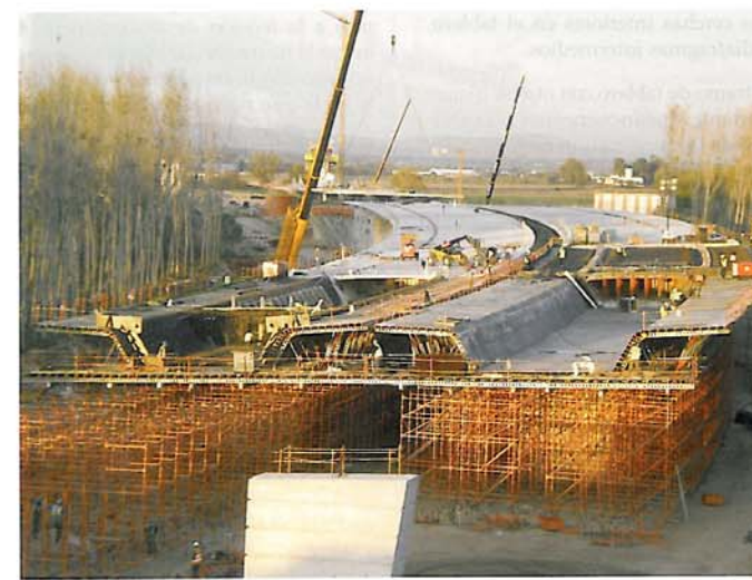
Figura 37. Frente de avance de los tableros gemelos del viaducto. Construcción por vanos sucesivos Figure 37. Construction front for the twin decks on the viaduct: span-by-span construction
