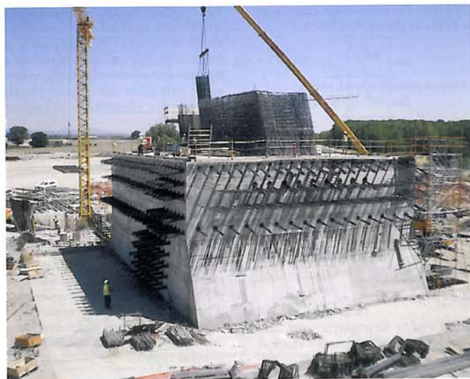
Figura 26. Mamparo en hormigón gris. Arranque de armado de pylon y pretensado transversal del mamparo Figure 26. Grey concrete bulkhead: pylon reinforcement springing and transverse prestressing in bulkhead
