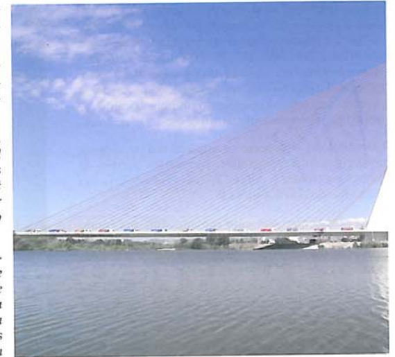
Figura 44. Prueba de carga Figure 44. Load trial
