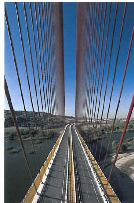
Figura 13. Tirantes de sustentación del tablero en dos planos de 38 cables cada uno Figure 13. Deck stays on two planes containing 38 cables each
