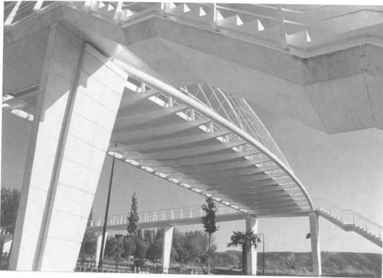
Vista inferior pasarela Talavera de la Reina.
