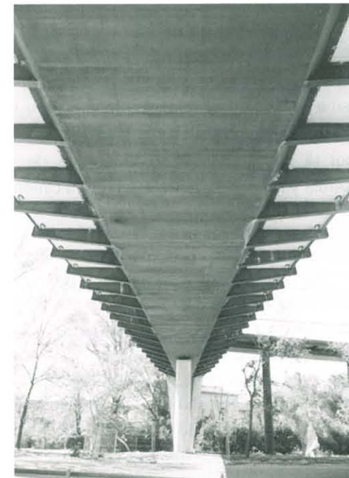
Vista inferior de la pasarela
