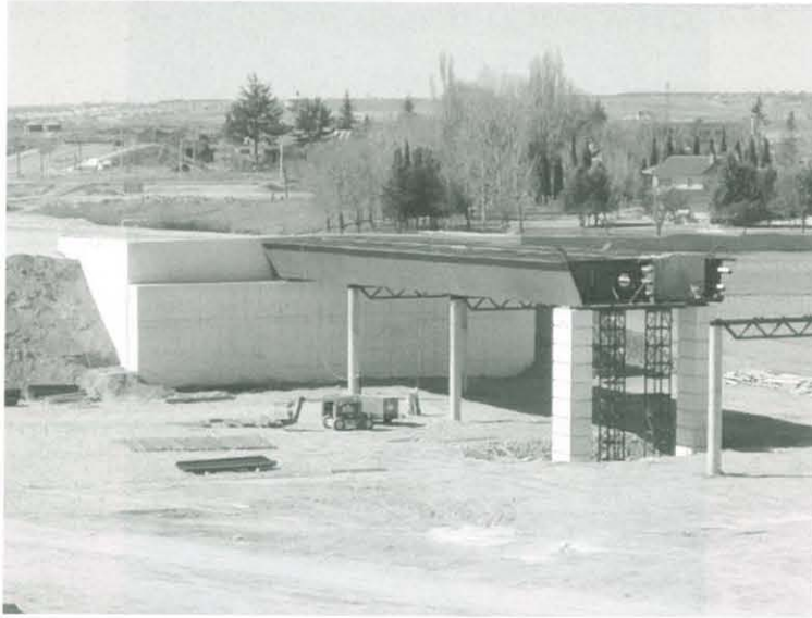
Fase de montaje del cajón del Atirantado de Guadalajara.
