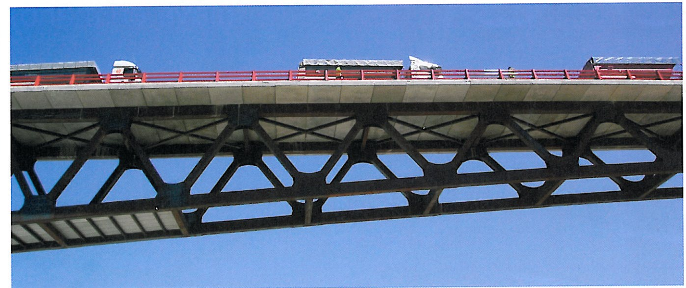
Las celosías están conectadas por arriostramientos metálicos y por la losa superior de hormigón.
