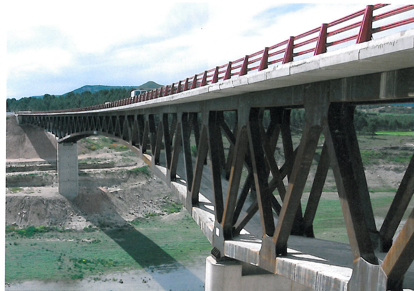
La cuota de fluctuación del embalse fue uno de los condicionantes a la hora de concebir la estructura a proyectar.
