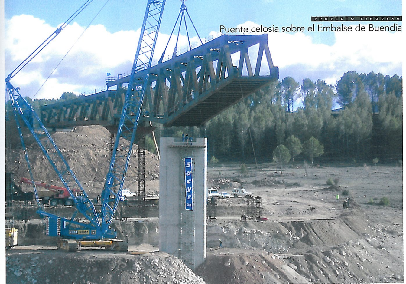
Las celosías están conectadas por arriostramientos metálicos y por la losa superior de hormigón.
